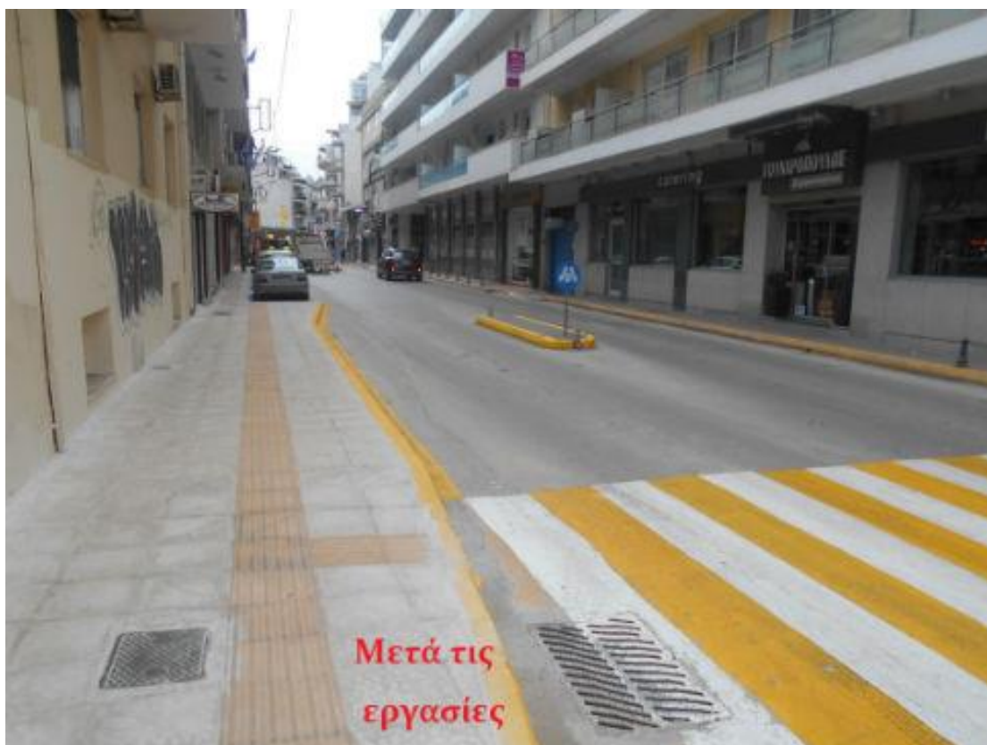
Εικόνα 21 Διαπλάτυνση πεζοδρομίων στην Οδ. Γοβιού στη Χαλκίδα.
