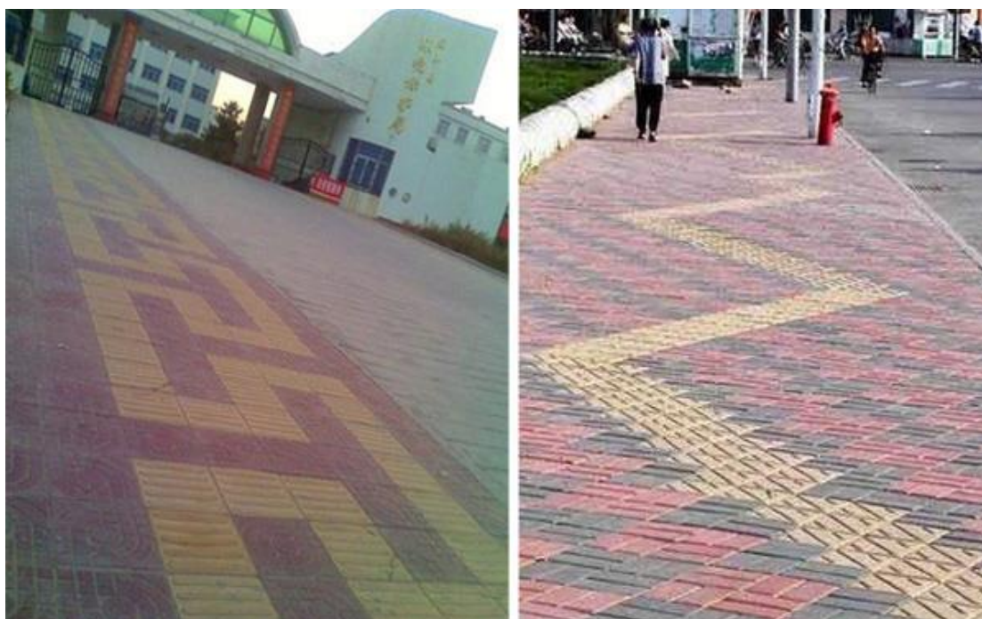
Εικόνα 16 Λωρίδα κίνησης τυφλών στην Κίνα. Ο σχεδιασμός είναι δυσλειτουργικός αφού δεν επιτρέπει την ευθύγραμμη κίνηση των τυφλών αλλά ενδέχεται να δημιουργήσει συγχύσεις.
