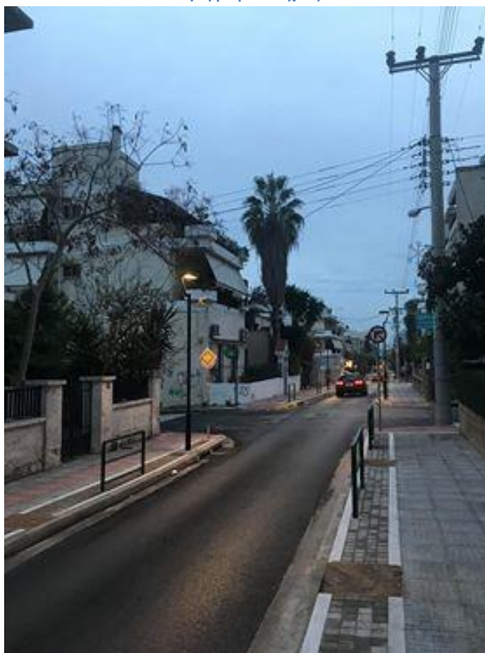
Εικόνα 7 Ανάπλαση στην οδό Πριάμου στο δήμο Αγίου Δημητρίου Αττικής. Έργα διαπλάτυνσης πεζοδρομίων και τοποθέτηση μικρού πάχους ιστών.
