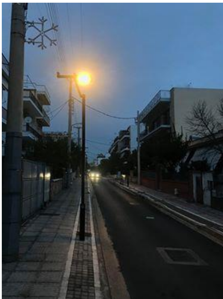
Εικόνα 8 Ανάπλαση στην οδό Πριάμου στο δήμο Αγίου Δημητρίου Αττικής. Έργα διαπλάτυνσης πεζοδρομίων και τοποθέτηση μικρού πάχους ιστών.
