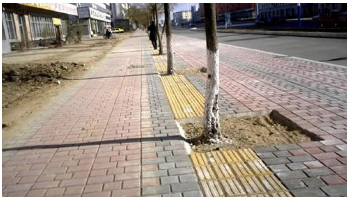
Εικόνα 15 Λωρίδα κίνησης τυφλών στο Πεκίνο, Κίνα. Ο σχεδιασμός ενδέχεται να προκαλέσει ατύχημα αφού η λωρίδα διακόπτεται από φυτεύσεις.
